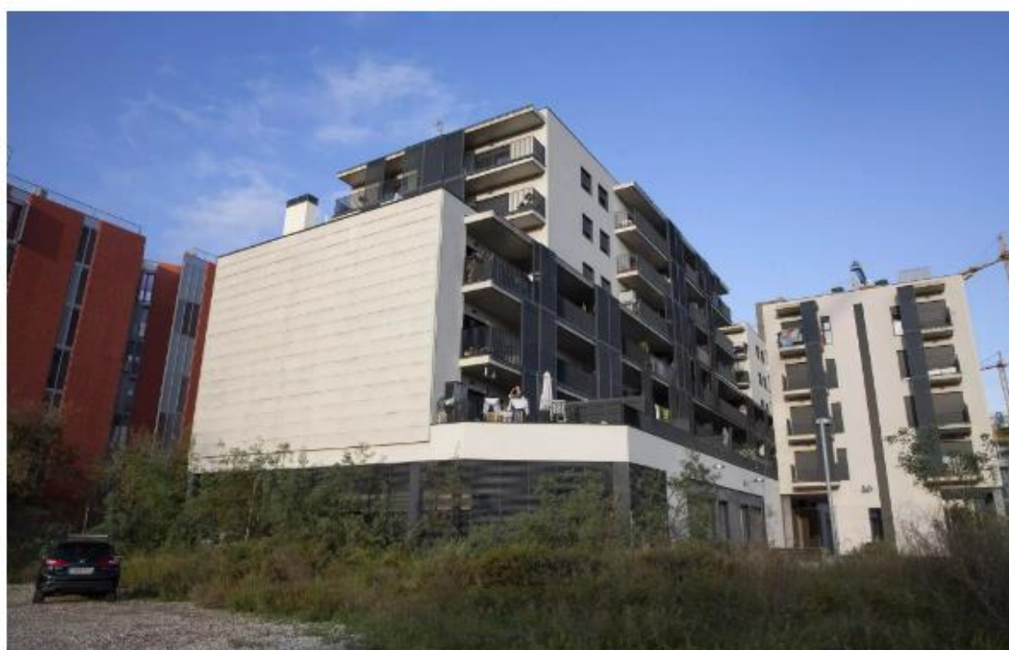
Bloque de pisos de protección oficial de la Marina del Prat Vermell con problemas con el agua caliente y calefacción / ELISENDA PONS
